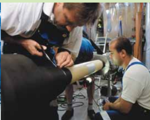
Kabelstykker samles med muffer, som altid foregår på stedet.
