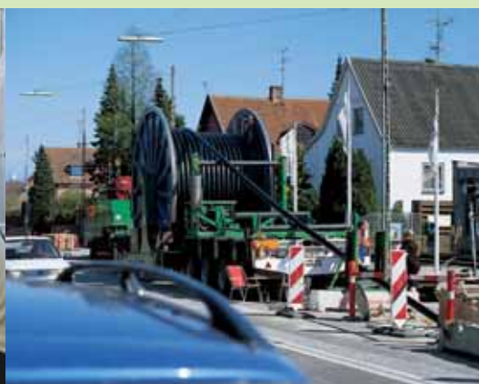
Udlægning af kabel i boligkvarter.
