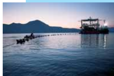
Udlægning af søkabel.
